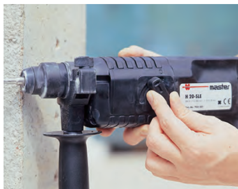
Со ударна бургија избушете дупка за типла
