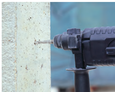
Со ударна бургија избушете дупка за типла
