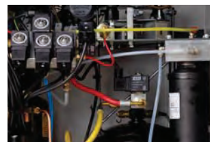
Нов тип на пречишувач и 2 вентилатори кои овозможуваат долг период на работа со сервисната станица
