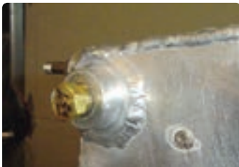
Заварен спој на испустот на резервоарот
