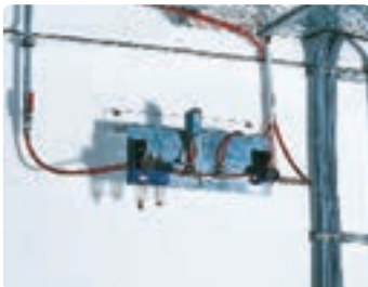
Работилничка пневматска инсталација
