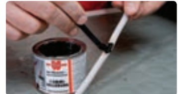
Поправка на оштетена изолација на водилката
