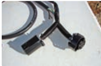
Повлекување на каблите низ термособирачко црево
