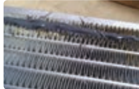
Пукнатина на ладилник
