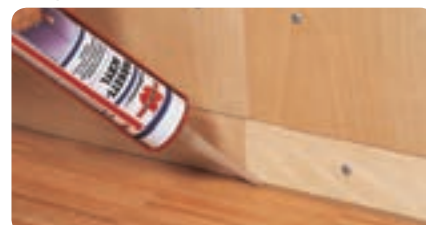
Заптивање процепи помеѓу сидот и паркетот
