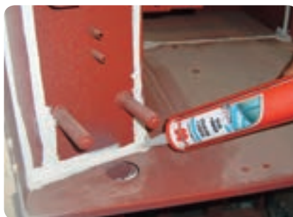
Заптивање на елементи на челична конструкција
