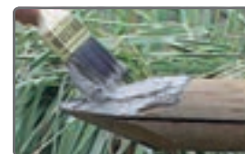
Водоотпорна заштита на дрво
