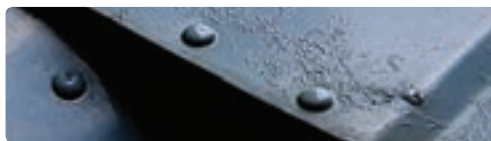
Челичен профил со испукана основна боја
