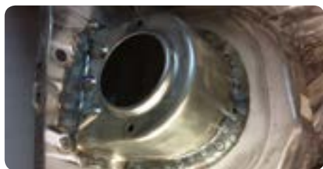
Точкасто заварување на метални површини
