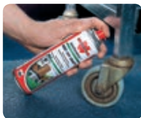
Демонтажа на кородиран спој на тркалца
