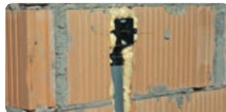
Пополнување штемувани сидови во фаза на изградбата
