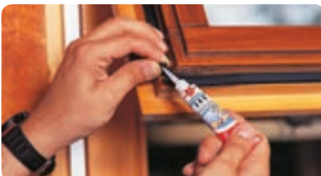
Лепење кедер на вертикални површини
