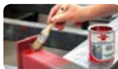
Челична конструкција офарбана со основна боја оксид црвена
