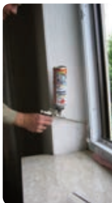
Нанесување PUR пена со пиштол
