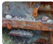
Челична конструкција со видливи знаци на јака корозија
