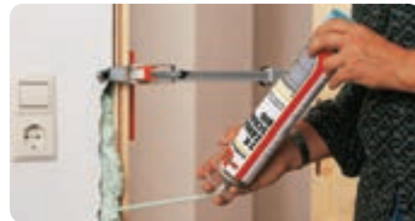
Фиксирање на каса за врата
