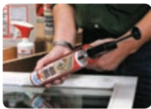
Заптивање на Алу/ПВЦ профил
