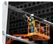
Фарбање на челична подконструкција
