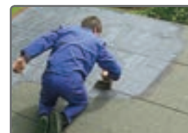
Заштитен водоотпорен слој на покрив
