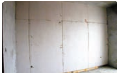
Поставување изолација и гипсени плочи
